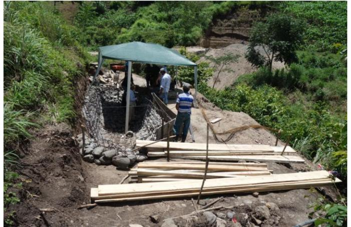
Bau des Sandabscheiders –im Hintergrund der Aushub für den Tank
